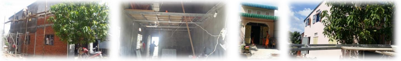
사진설명: [좌측 2장] 공사 중 / [우측 2장] 공사 완료 후
